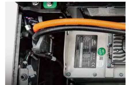
Sichere Installation der Batterie: Der Netzstecker ist im Fahrzeug befestigt.
